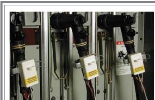
Indicador de Falla de Corriente Trifásica en una aplicación de interruptor.
